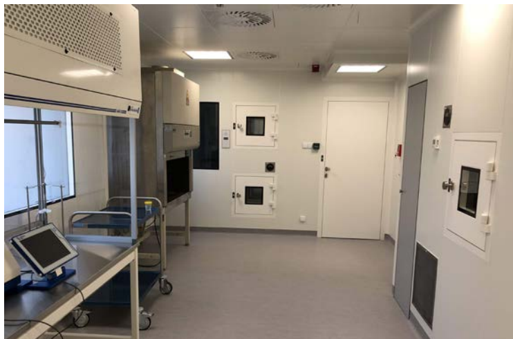
Zabudowa modułowa dla klasy czystości A w otoczeniu B
